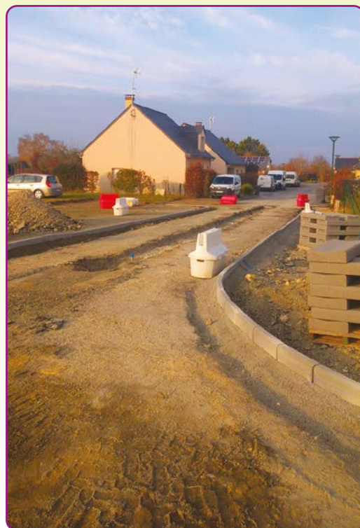
Travaux aux Mortiers
