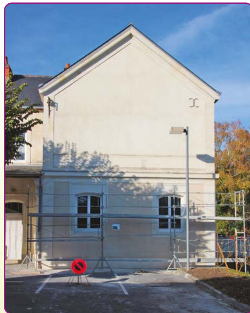
Travaux à la mairie
